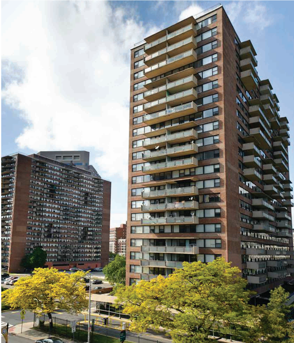
La excavación de Metropolis Towers finalizó en junio de 2014 con el control continuo del aire, lo que indica que la calidad cumple sin problemas con las normas de NJDEP.
